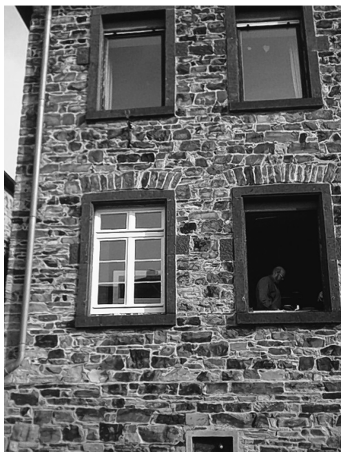
Einbau der neuen Fenster im Pfarrhaus Löhndorf
