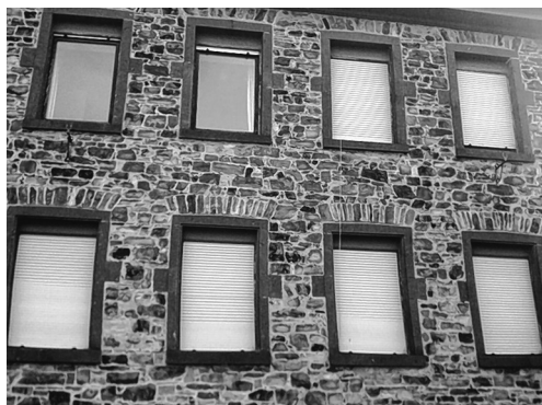
Das Pfarrhaus Löhndorf vor der Sanierung der Fenster
