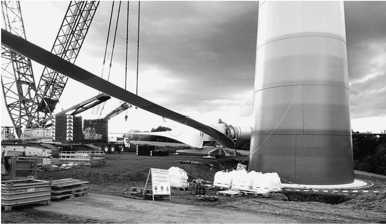
*Neue Dimensionen: der Fuß eines Windrades, das 145 Meter Höhe misst, die Rotorblätter haben einen Durchmesser von 90 Metern – eine Anlage dieser Leistungsklasse steht in Weibern und liefert Strom für bis zu 1.000 private Haushalte.*
