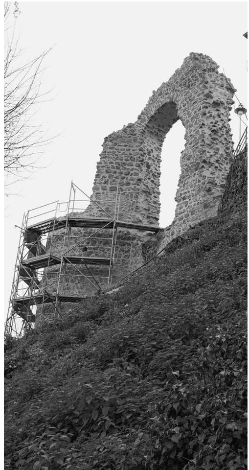
*Restaurierungsarbeiten am Rolandsbogen 2010, bei denen u.a. der zerstörerische Efeubewuchs entfernt wurde.*
