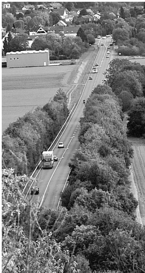
Blick auf die B 266 von Lohrsdorf in Richtung Bad Bodendorf, 2011
