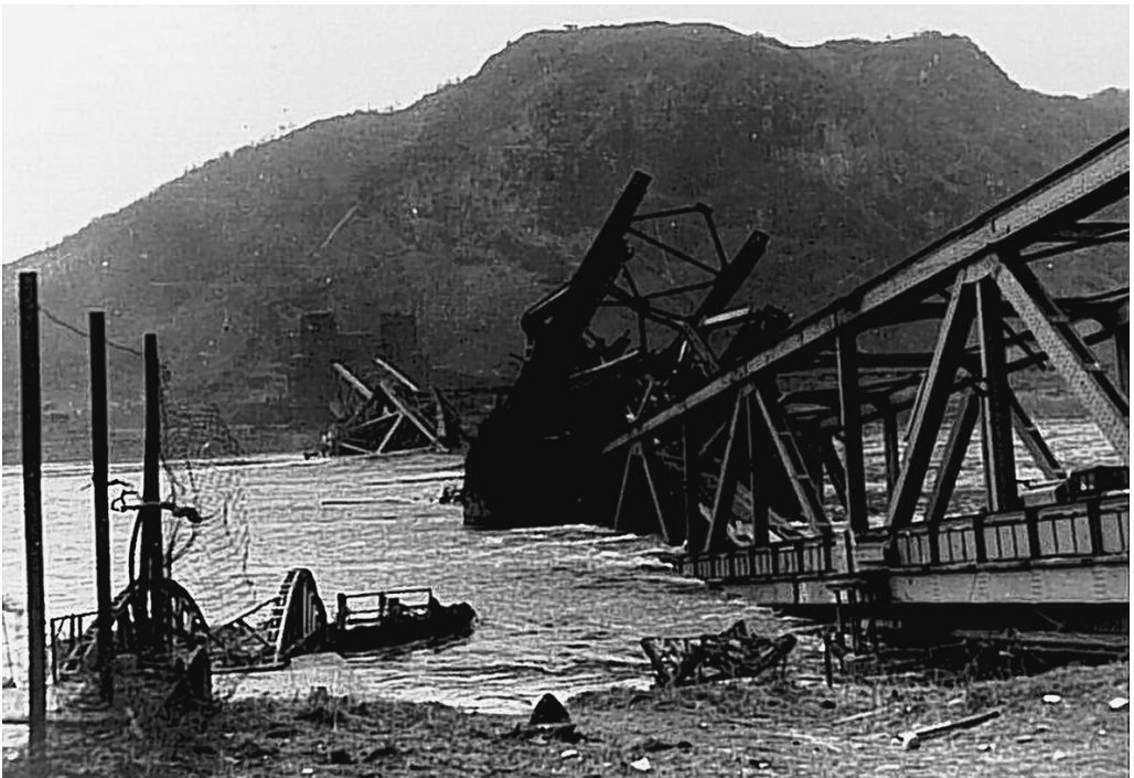
Die zerstörte Eisenbahnbrücke vom Remagener Ufer aus, Frühjahr 1945
