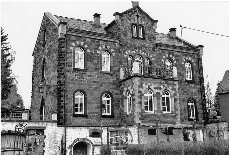
Das von Pastor von Freyhold als Pfarrhaus vorgesehene Haus wurde als Amtsgebäude genutzt und ist inzwischen ein Privathaus.
