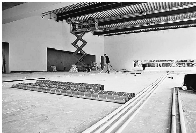
Hier entsteht die große Mensa.
