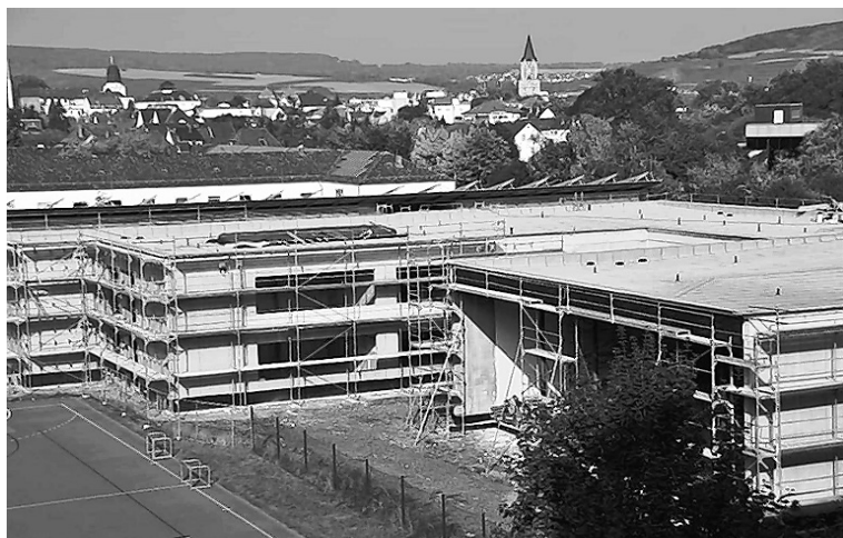
Baustelle Are-Gymnasium im September 2009: Der Neubau ist als Passivenergiehaus konzipiert.
