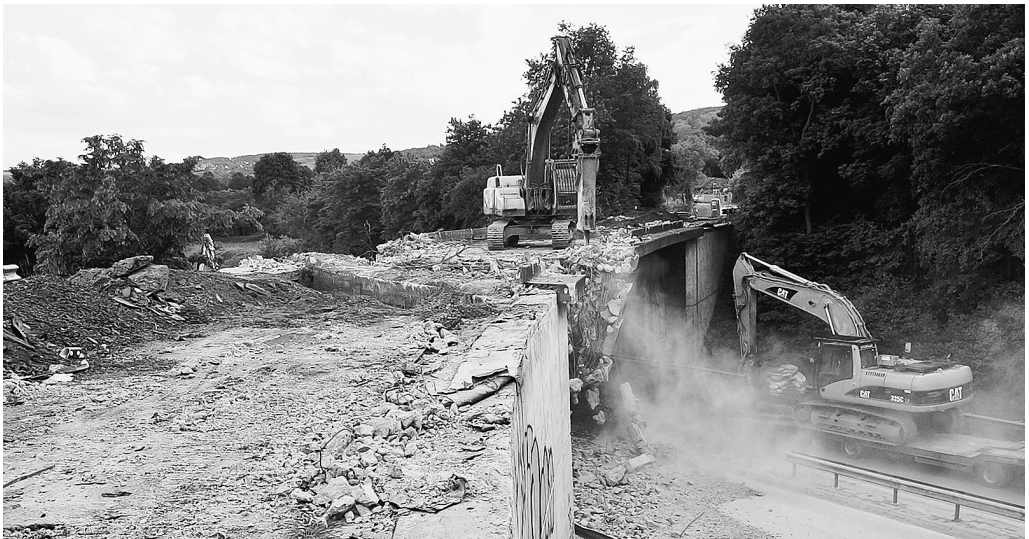
Schweres Gerät im Wochenenddienst: Die alte B 9-Brücke bei Remagen weicht einer neuen.
